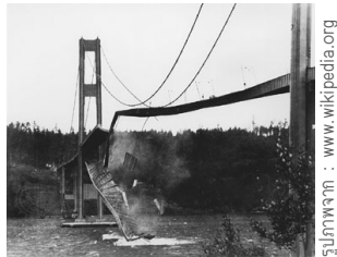
ภาพสะพานทาโคมา (Tacoma Narrows Bridge) ในปี 1940 ที่เกิดจากความผิดพลาดในการออกแบบทำให้สะพานเกิดการสั่นพ้อง (Resonance) กับลมที่พัดผ่านสะพาน ทำให้สะพานเกิดการสั่นอย่างรุนแรงและเสียหายในที่สุด
